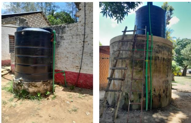
2. Der Brunnen der Schule war nicht mit den Tanks verbunden, so dass die Arbeiter umständlich Tank für Tank in der Schule mit Wasser befüllen mussten. Mit Hilfe der lokalen Unterstützerinnen und Unterstützer gelang es uns, die Tanks an einen Haupttank anzuschließen, der die anderen Tanks mit Wasser versorgt. Dies spart Zeit und Strom, da jetzt das Wasser nur in den Haupttank gepumpt werden muss und dann über die angeschlossenen Rohre ungehindert in die anderen Tanks fließen kann.
